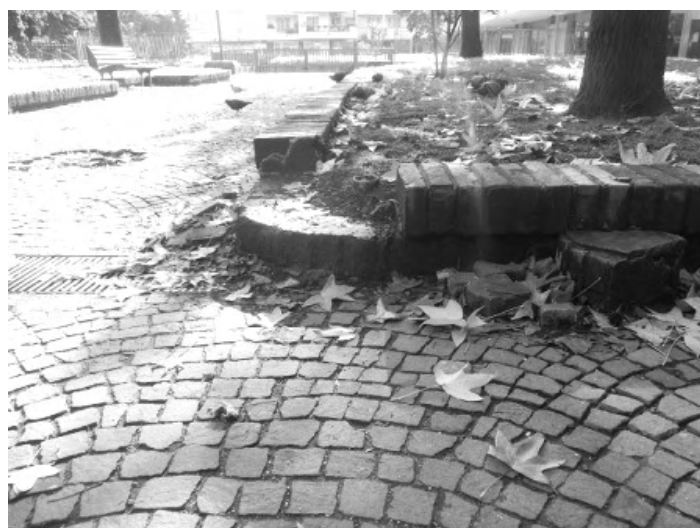
Giardini del Vescovo: in alto un'aiuola col cornicione rotto, a sinistra un esempio delle condizioni generali della pavimentazione
