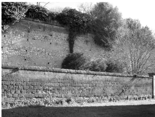
Una porzione del muraglione posteriore, a rischio di crolli
